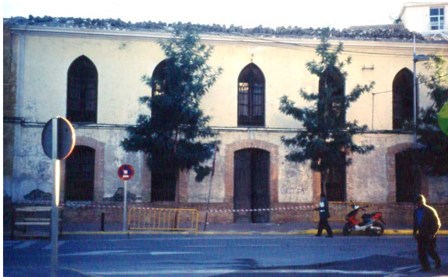
Vista de la fachada del Convento poco antes de su demolición, en la misma se puede apreciar como su cubierta ya ha sido desmontada.
