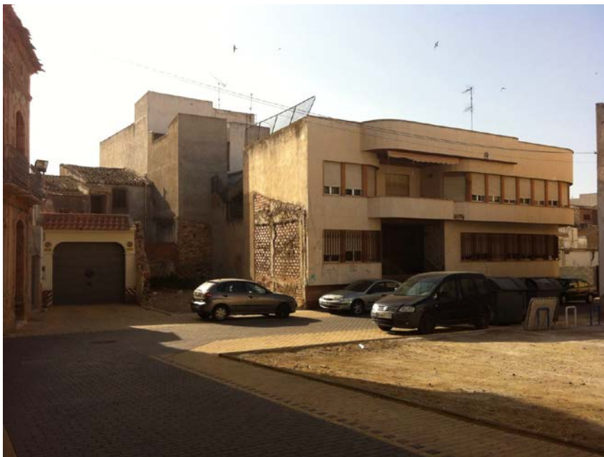
Plaza Calle Luna con Calle Melchor Ballesta, a la que recientemente se le ha renovado el pavimento con la colocación de adoquines pero a la que le faltan elementos que den carácter de placeta y la doten de personalidad
