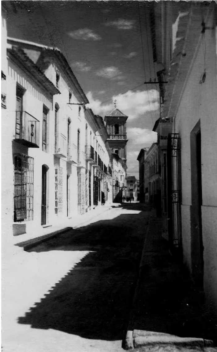
Imagen de la Calle Enrique García a mediados del s. XX, en ella podemos observar como el pavimento de la calzada es de arena y el encintado de las aceras presenta el mismo trazado que el existente en la actualidad. En la misma también se puede apreciar como el ritmo y modulación de las fachadas que la conforman era más constante y armónico de lo que lo es en la actualidad.
