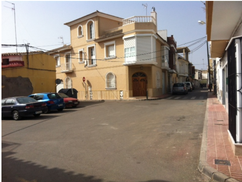
Placeta existente en el cruce de Calle Arrieros, Calle Palmera y Melchor Ballesta,, como otras carece de tratamiento como placeta , su uso se reduce a acoger contenedores y vehículos estacionados.
