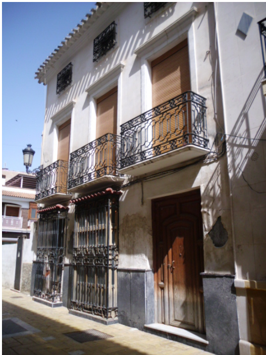
Calle Centro, 20 (tipo C)
