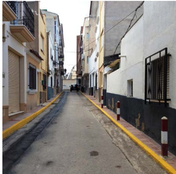
Calle Ciprés. Calle con aceras insuficientes, el tránsito peatonal por las aceras es imposible, esta es un ejemplo claro de calle que debería modificarse su diseño para hacerla más funcional y accesible
