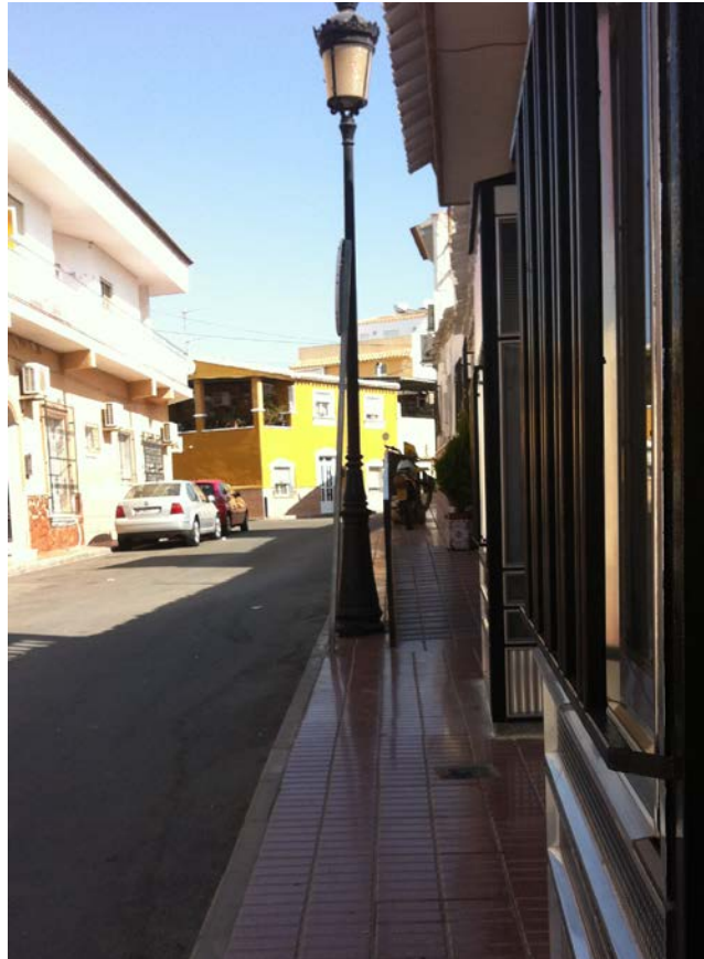
Calle ejemplo de cómo no debe ser una calle. Reforma realizada con un diseño contrario a la normativa junto con una inadecuada elección de mobiliario y materiales convierten la acera de esta calle en inaccesible e impracticable para el peatón.
